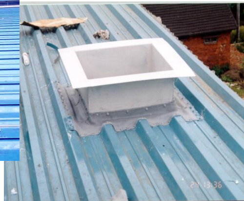
因屋面板搭接处有纵向位移，故可采用得泰条形盖片密封防水
