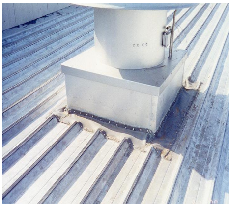
屋面波峰较高，采用方型底座结构过度
