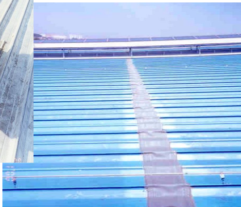
因屋面板搭接处有纵向位移，故可采用得泰条形盖片密封防水
